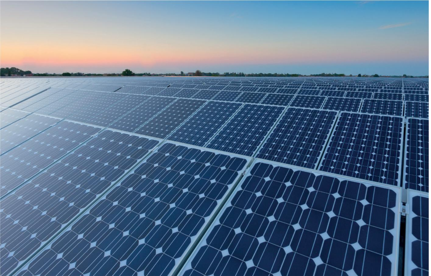
**Une centrale photovoltaïque est un système qui utilise des cellules solaires pour convertir l'énergie solaire en électricité. Les cellules solaires sont fabriquées à partir de matériaux semi-conducteurs tels que le silicium et sont disposées en panneaux solaires.**
